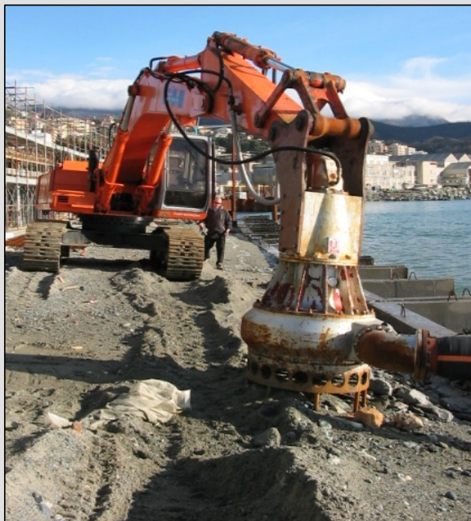
Насос DPH300 Строительные работы
