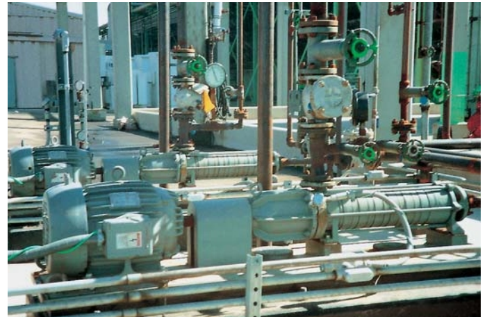
Тип NHL с одинарным механическим уплотнителем. Среда: горячая вода, 210 °C
