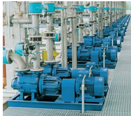
Тип HZSM с магнитной муфтой. Среда: растворитель, 20 °C
