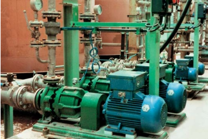
Тип NML с магнитной муфтой. Среда: метанолхлорид, 40 °С
