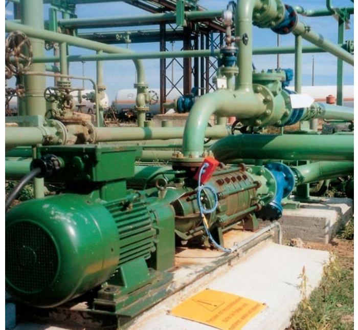
Тип HZSMA с магнитной муфтой. Среда: пропан, бутан, 20 °С
