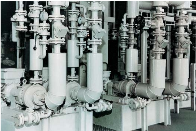
Тип NKL с одинарным механическим уплотнением. Среда: охлаждающая вода, 20 °С
