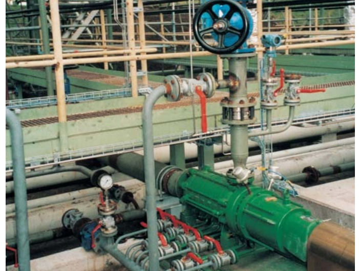
Тип NCR API 610 (7-я версия) с одинарным механическим уплотнителем. Среда: авиационное топливо JP4
