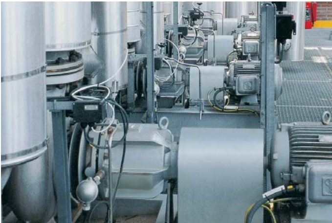
Тип NMW с магнитной муфтой. Среда: горячее масло, 350 °C
