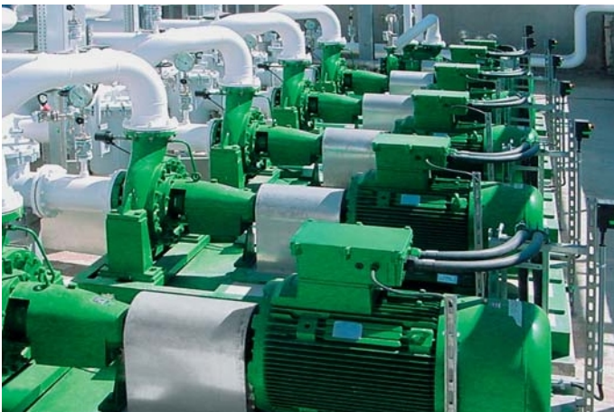
Тип SCM с магнитной муфтой. Среда: метанол, 40 °C
