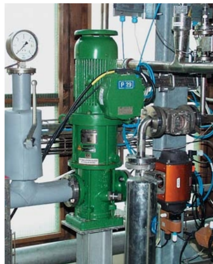
Тип NCL с одинарным механическим уплотнением. Среда: деминерализованная вода, 40 °С
