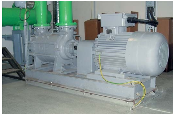
Тип HZS с одинарным механическим уплотнением. Среда: бензин, 20 °С
