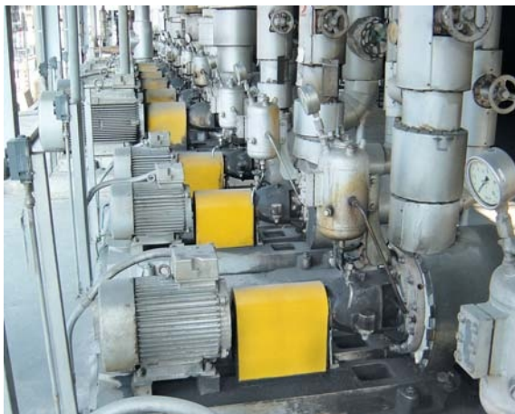
Тип NML с магнитной муфтой. Среда: уксусная кислота, 130 °С
